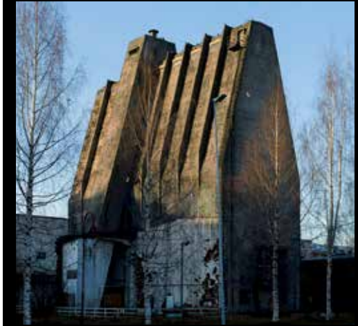
Le silo Toppila, au nord de la Finlande. Ph. © Otto Lowe.
