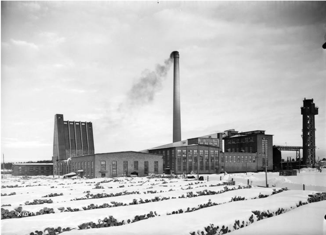
Fábrica de celulosa de Toppila
