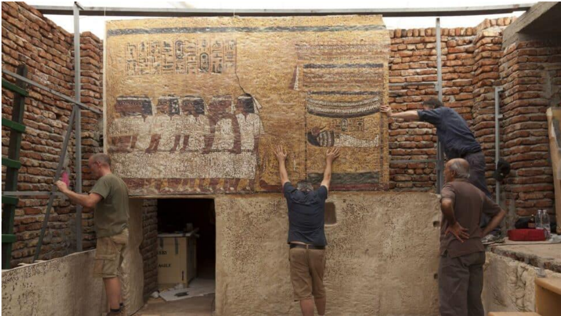
Instalación de los paneles de la réplica de la tumba de Tutankamón. FACTUM ARTE
